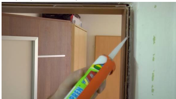
nanesení transparentního akrylátového tmelu do drážky v ostění
