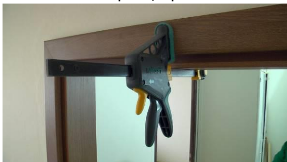
zajištění zárubně montážní svěrkou
