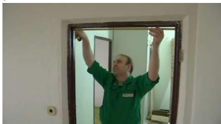
přeměření velikosti stavebního otvoru zkušební instalace zárubně
