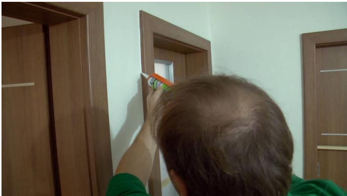
zakrytí spár pomocí akrylátového tmelu
