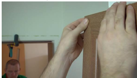
kontrola sestavení zákloповé části zárubně
