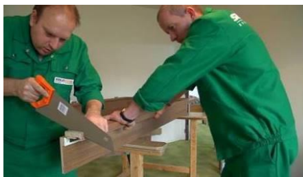
seříznutí zárubně do požadované délky
