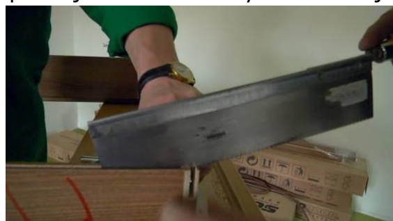
proříznutí drážky v ostění
