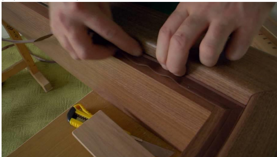
instalace těsnění
