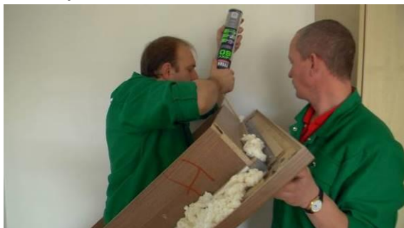
nanesení nízkoexpanzní montážní pěny do nosné části zárubně
