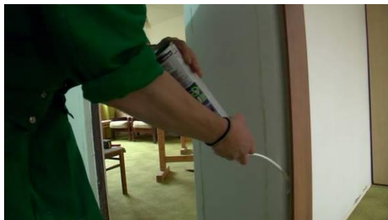
vyplnění mezer mezi stěnou a zárubní nízkoexpanzní montážní pěnou
