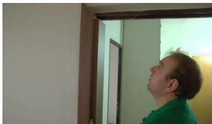
přeměření velikosti stavebního otvoru zkušební instalace zárubně
