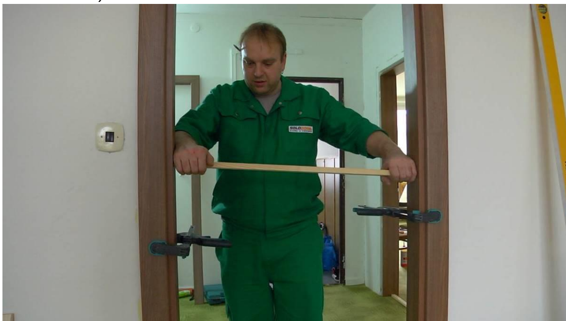
instalace rozpěr pro důkladné zatuhnutí montážní pěny v předepsaných rozměrech
