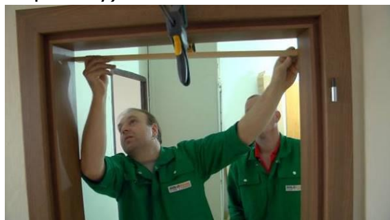
přeměření velikosti průchozího otvoru
