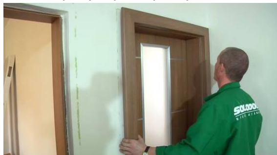
instalace zákloповé části zárubně
