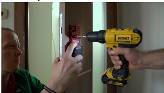
předvrtání otvorů s pomocí montážní šablony
